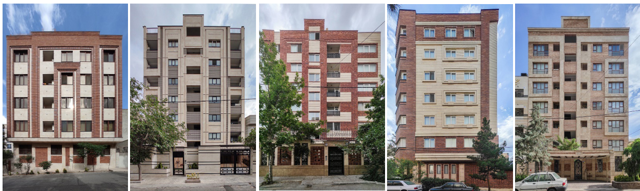
تصویر شماره ۲: تصویر برخی از ساختمان‌های نمونه جدیدالاحداث در محله حکیمیه با نمای ترکیبی
