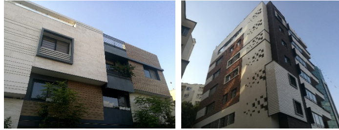
تصویرهای شماره ۲۱: نمونه آپارتمان در محله مرفه شیراز
